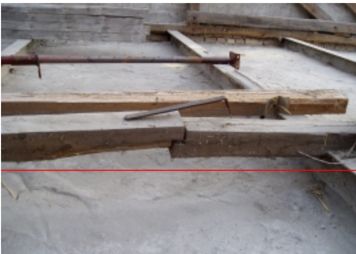
Foto 2: unzureichende Längsverbinding
