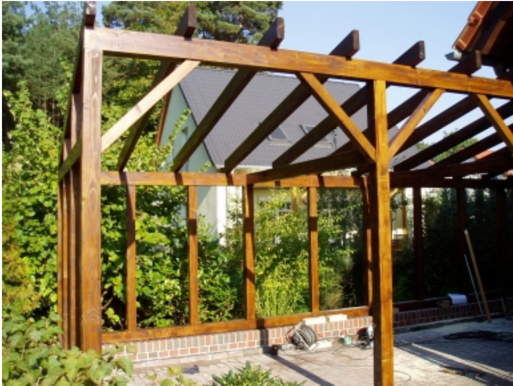
Ansicht von der Hofseite, Sparren sind montiert
