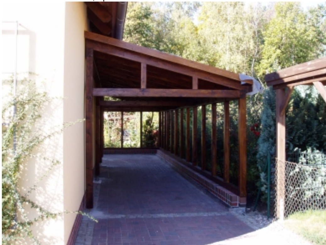
Ansicht von der Straßenseite, Holzbauarbeiten sind abgeschlossen
