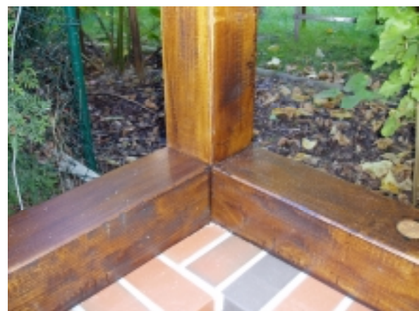
Eckdetail Wandschwelle: Eckblatt ohne sichtbare Verschraubung
