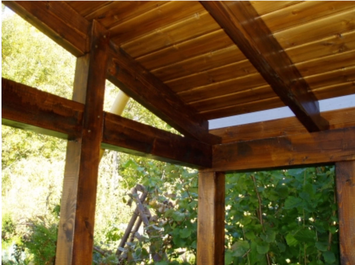
Unteransicht mit Sichtschalung, Sparrenausklinkung für Innenliegende Rinne im Eck erkennbar
