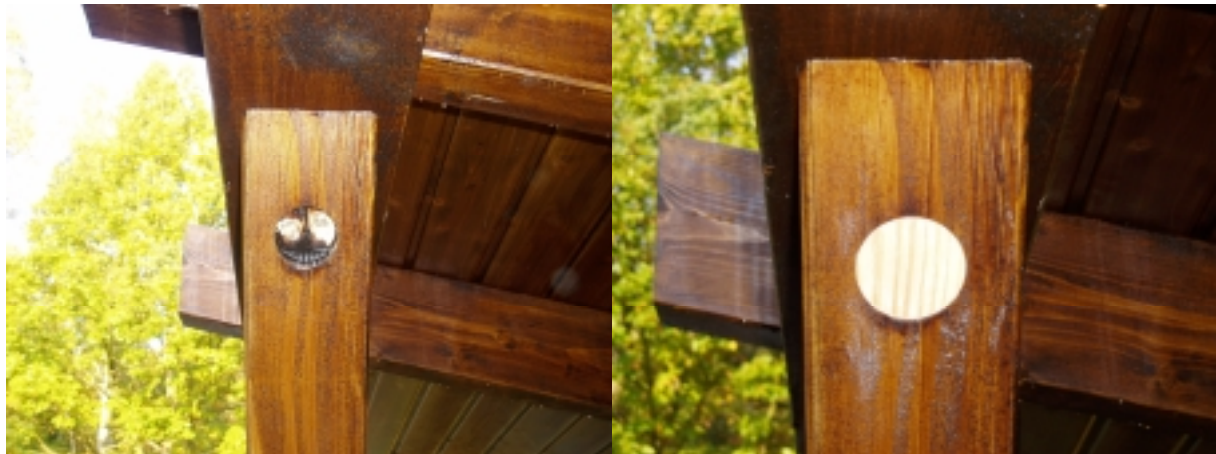
Detail: Verschluss der Ausfräsung für Kopfbandbefestigung mit Querholzdübel aus Kiefernholz
