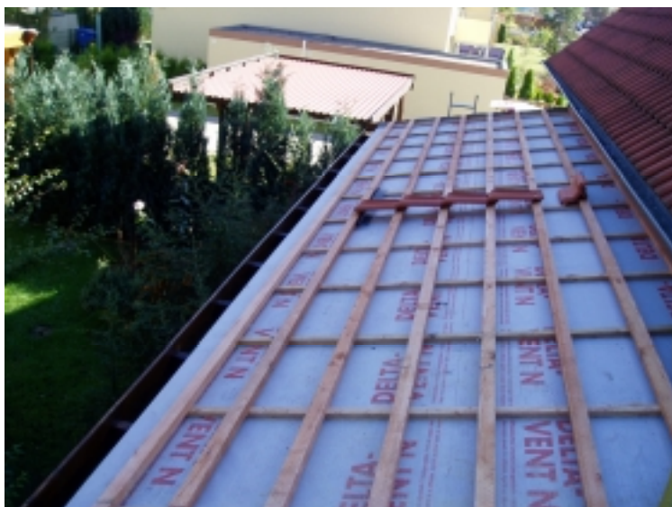
Die Traglattung ist montiert, Dacheindeckung mit Creaton Harmonie Tondachstein
