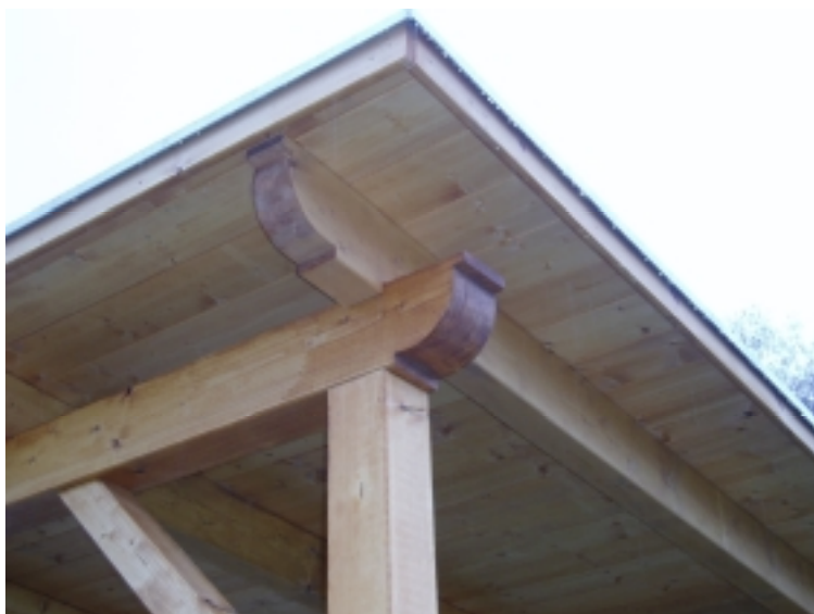
Detail: profilierte Balkenköpfe
