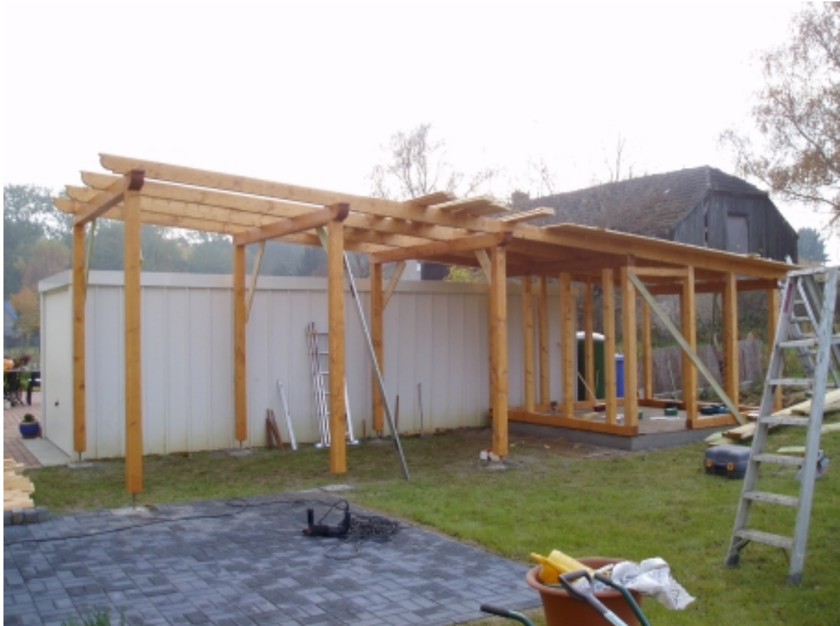
Aufbau des Carports: gut zu erkennen ist die solide Ständerkonstruktion
