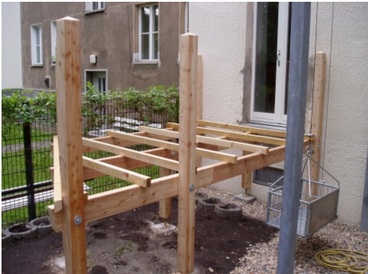
Der Lattenrost für den Belag ist montiert. Die Pfosten stehen auf 15 cm hohen Stützenfüßen, um den konstruktiven Holzschutz der Holzkonstruktion zu gewährleisten.
