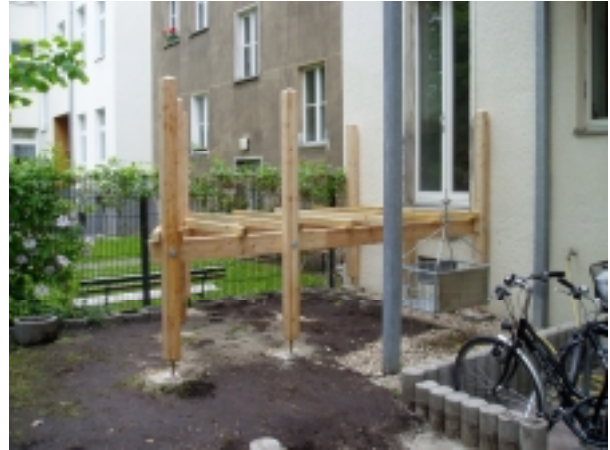
Die Terrassengrundkonstruktion ist gerichtet.
