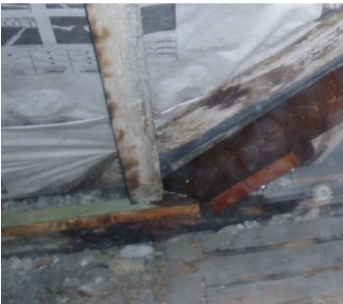
Foto 5: Sanierte Fußschwelle/ Kehlsparrenfuß
