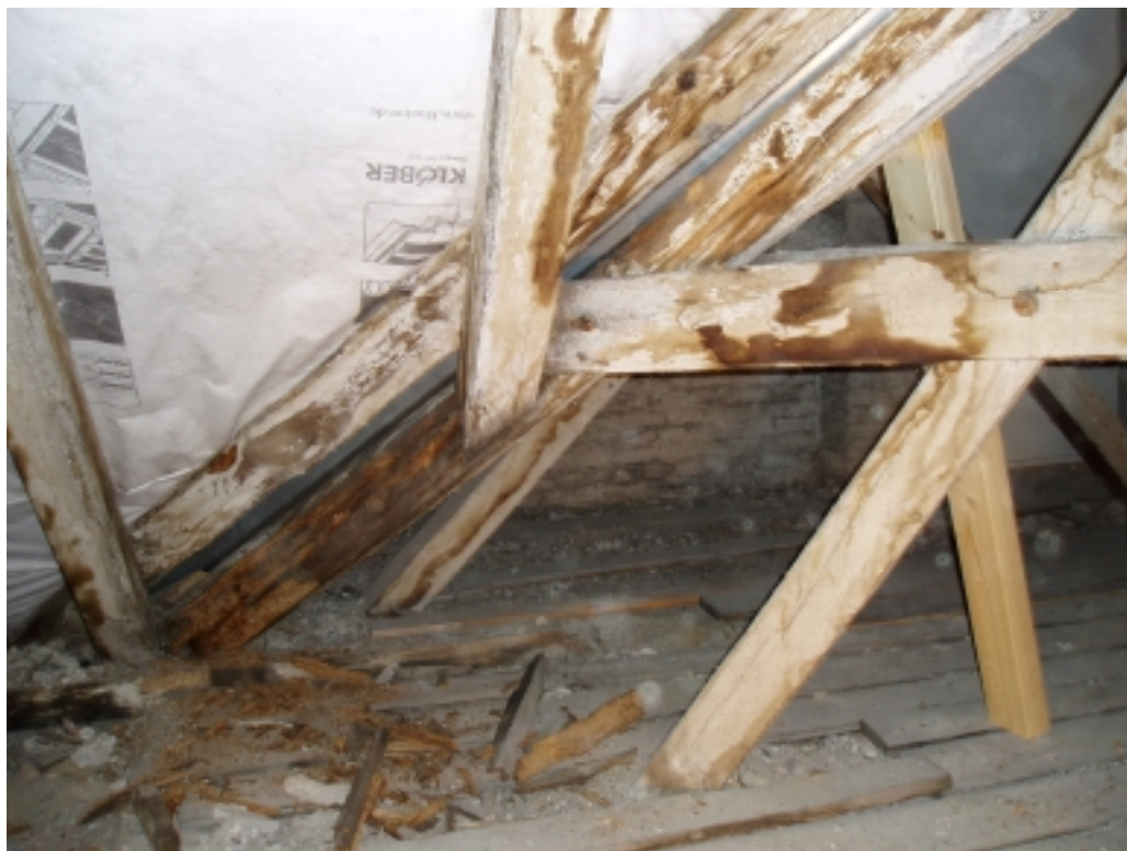
Foto 1: Kehlsparren vor der Sanierung
