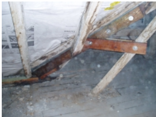
Foto 3: Kehle nach der Sanierung
