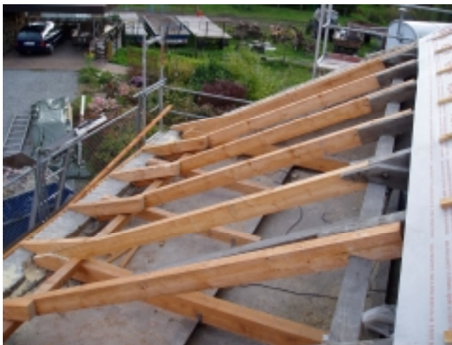
Foto 5: Sanierte Sparren
