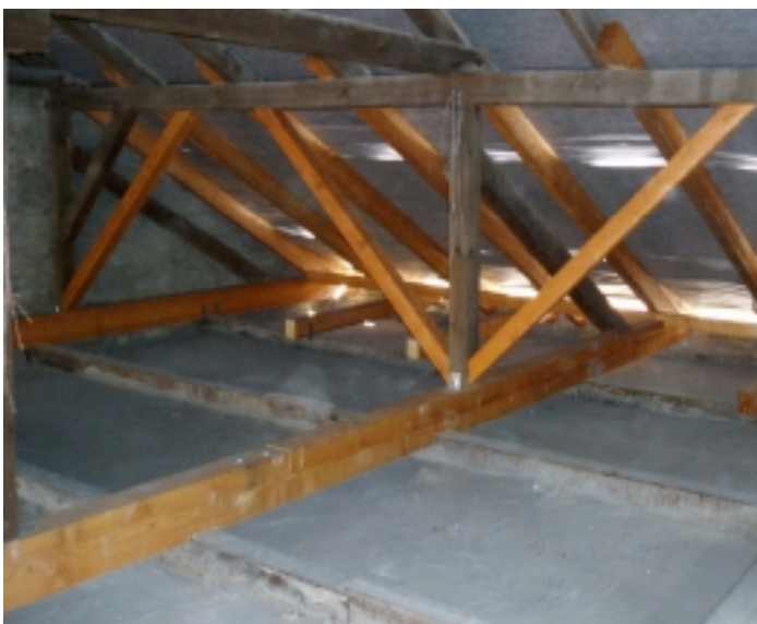
Foto 4: Sanierter Dachstuhl mit neu verbauten Hölzern
