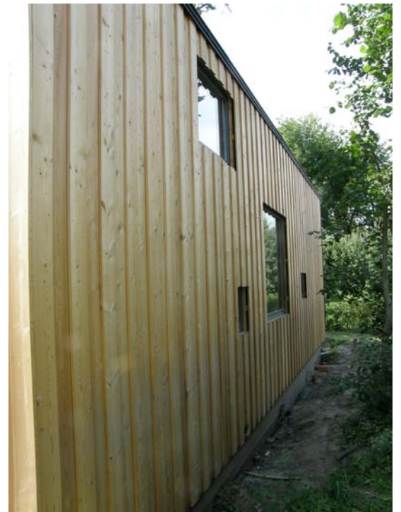
Die Holzrahmenwände werden mit einer hinterlüfteten Holzfassade als Boden-Deckel-Schalung aus Lärchenholz verschalt. Nach Fertigstellung des Daches beginnt der Innenausbau.
