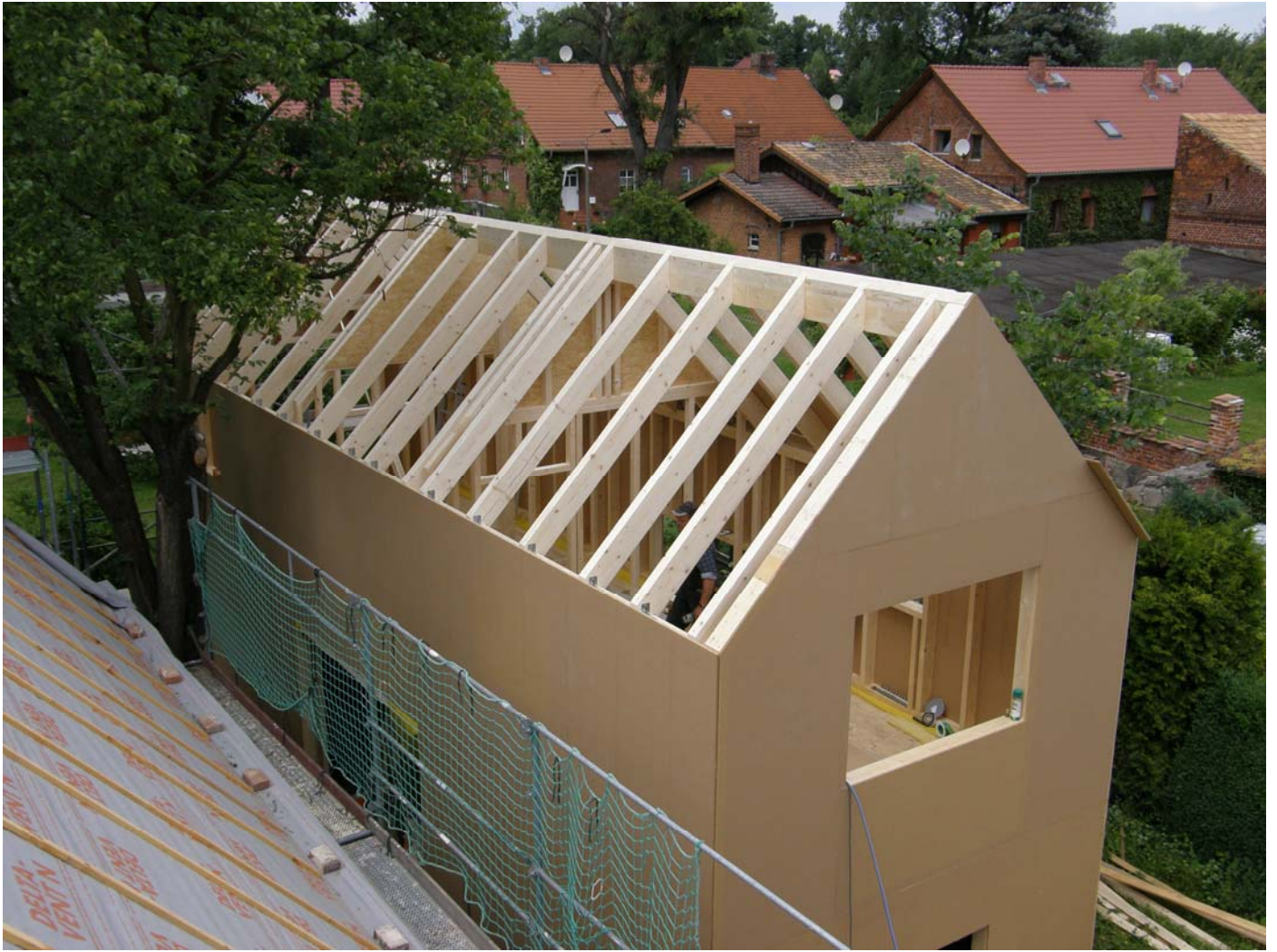
Die Holzrahmenwände werden mit einer hinterlüfteten Holzfassade als Boden-Deckel-Schalung aus Lärchenholz verschalt. Nach Fertigstellung des Daches beginnt der Innenausbau.
