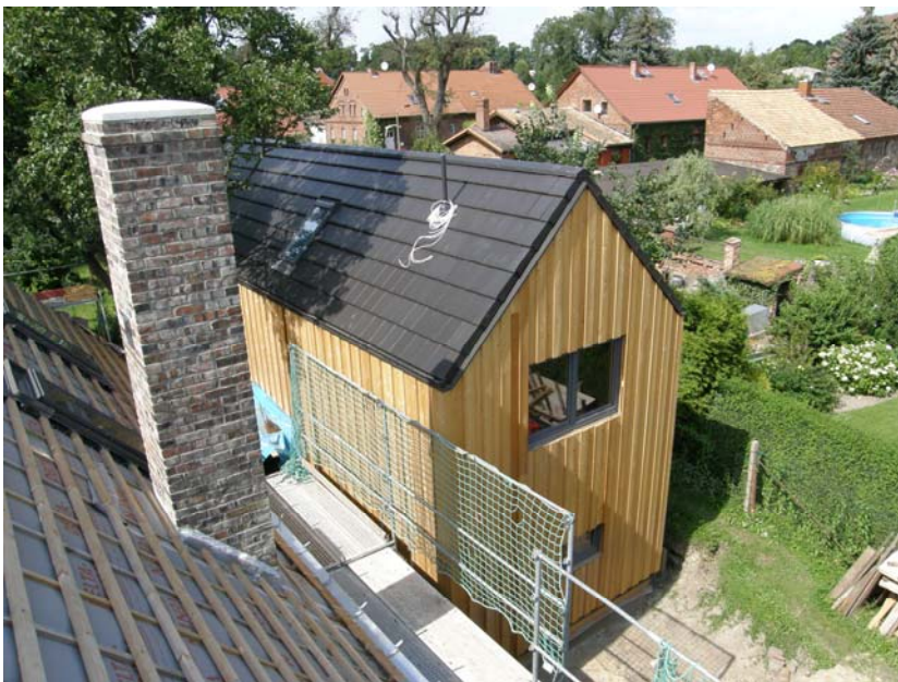
Die Holzrahmenwände werden mit einer hinterlüfteten Holzfassade als Boden-Deckel-Schalung aus Lärchenholz verschalt. Nach Fertigstellung des Daches beginnt der Innenausbau.
