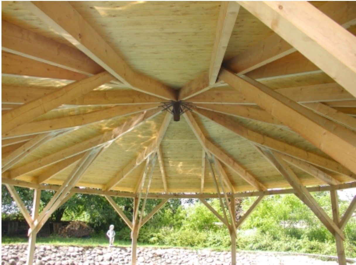
Unteransicht der Dachkonstruktion
