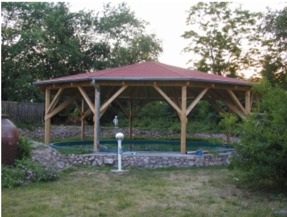
Dacheindeckung mit Bitumenschindeln (Rechteck)
